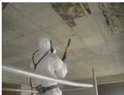
Entfernung von Spritzasbest
