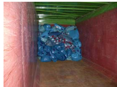
Asbestabfälle bereit für die Entsorgung
