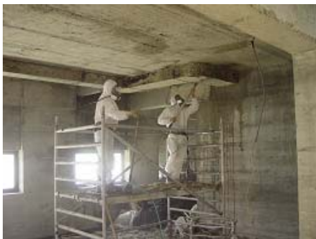
Entfernung von Spritzasbest
